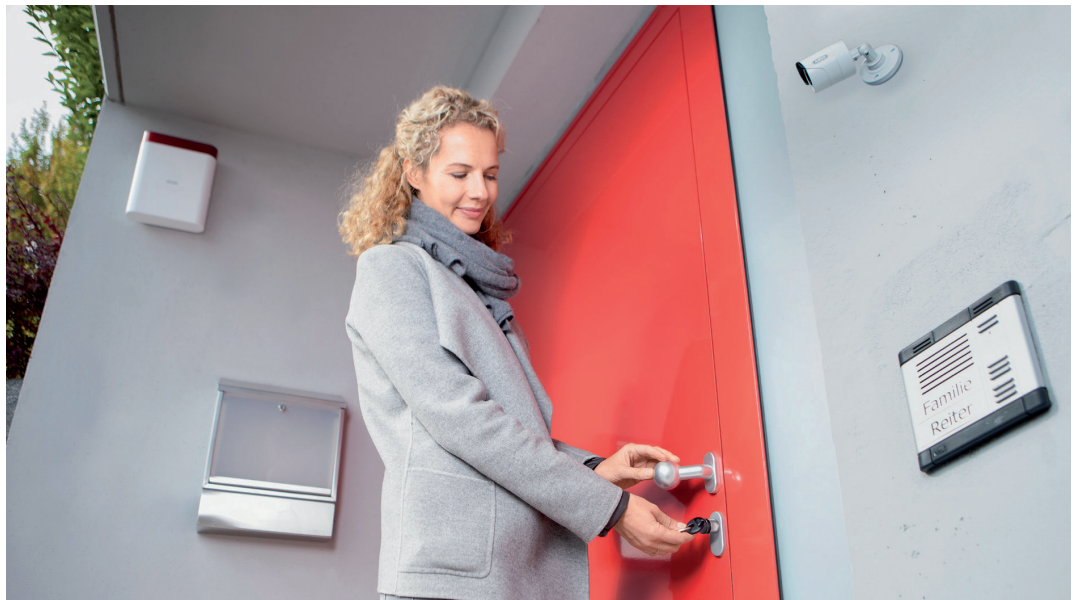
Positionierung einer Kamera im Bereich der Haustür
