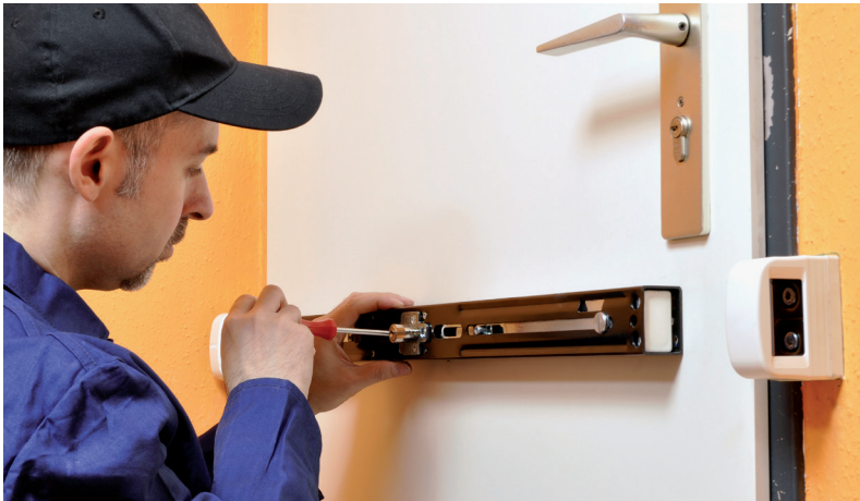
Installation eines Querriegels an der Eingangstür
